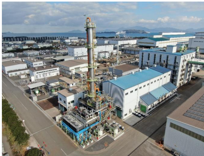
■ 若松工場 チタン精製プラント
