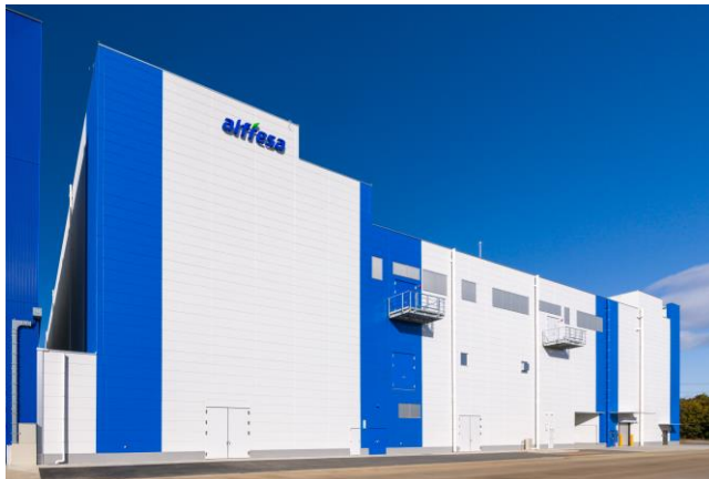
■アルフレッサファーマ 新製剤棟外観
